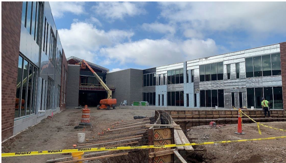
Se están formando y vertiendo los muros de concreto de las bases.
