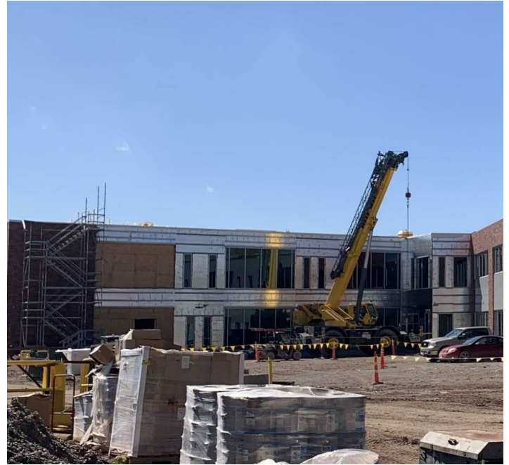
Se instalaron los paneles aislantes.
