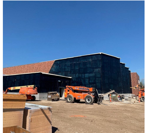
Esta en progreso la instalación de los paneles de piedra fundida y los remates del techo.
