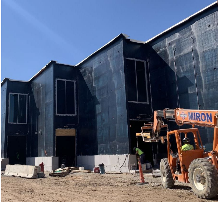
Se está avanzando con la instalación de la piedra fundida y el acristalamiento de las fachadas exteriores.
