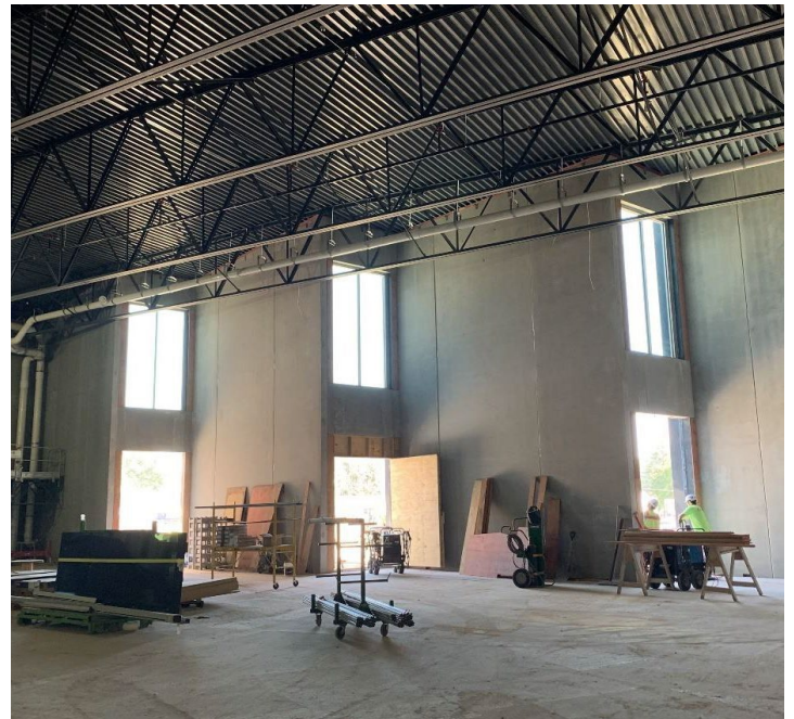
Está en progreso la instalación de la fachada exterior este en las paredes del gimnasio, así como la instalación de MEP.
