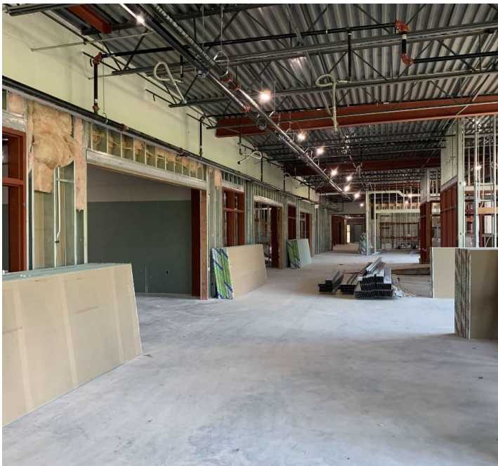
Está en marcha la instalación de la estructura metálica y de las tuberías del sistema de rociadores.
